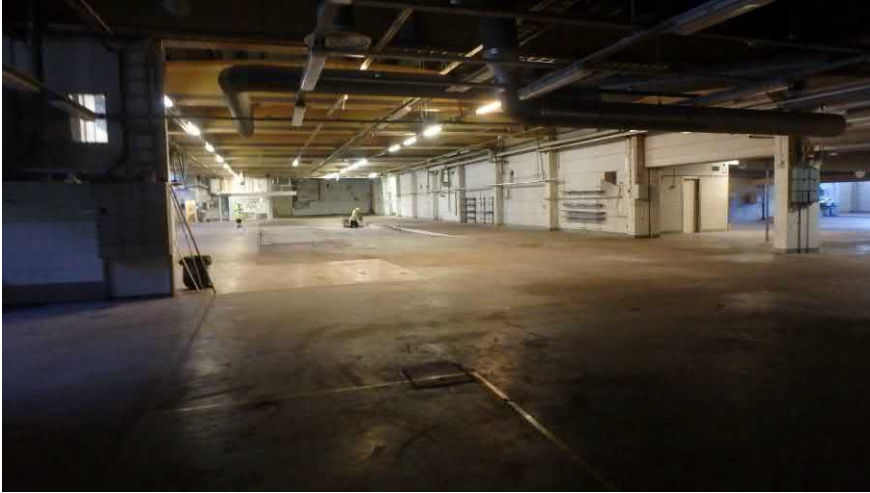
Takojankatu 6, leipomorakennus, tuotantopuolen iso halli 2018
