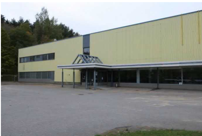
Takojanankatu 8 liikerakennus, itäsivu koillisesta 2018.
