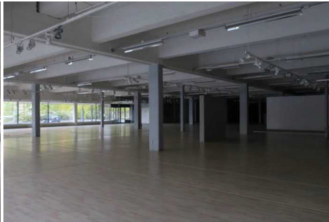
Takojankatu 8 liikerakennus, alakerta kaakkoon 2018.
