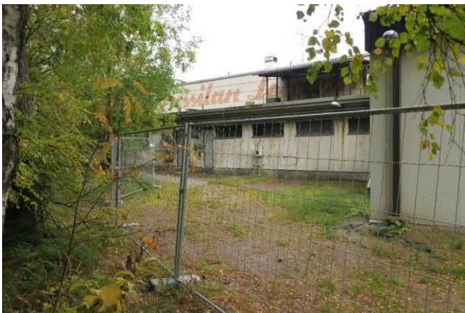
Takojanankatu 6 leipomorakennus, eteläsivua kaakosta 2018.
