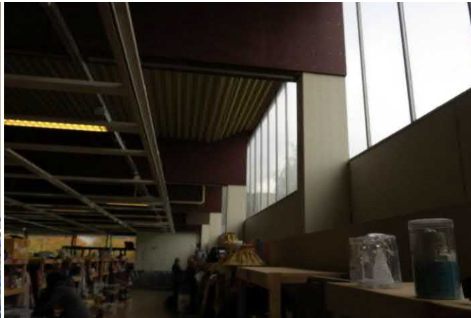
Takojankatu 8 liikerakennus, yläkerta länteen 2018. Yläosan ikkunanauhat.
